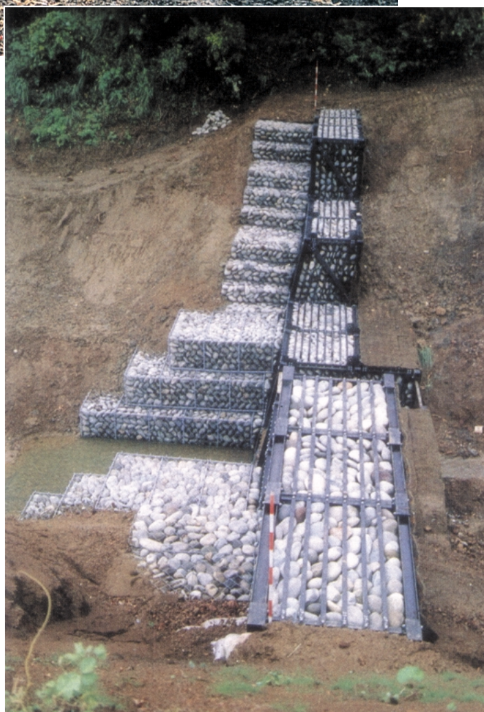
秀平地すべり対策工事【新潟県】
