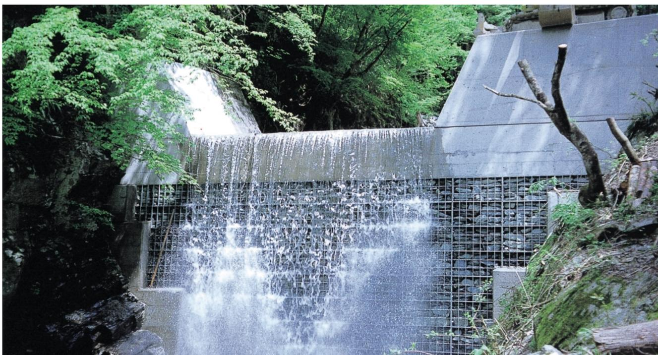
災害復旧後 喜内造谷えん堤 堤高7m、堤長12m 平成10年[奈良県]
