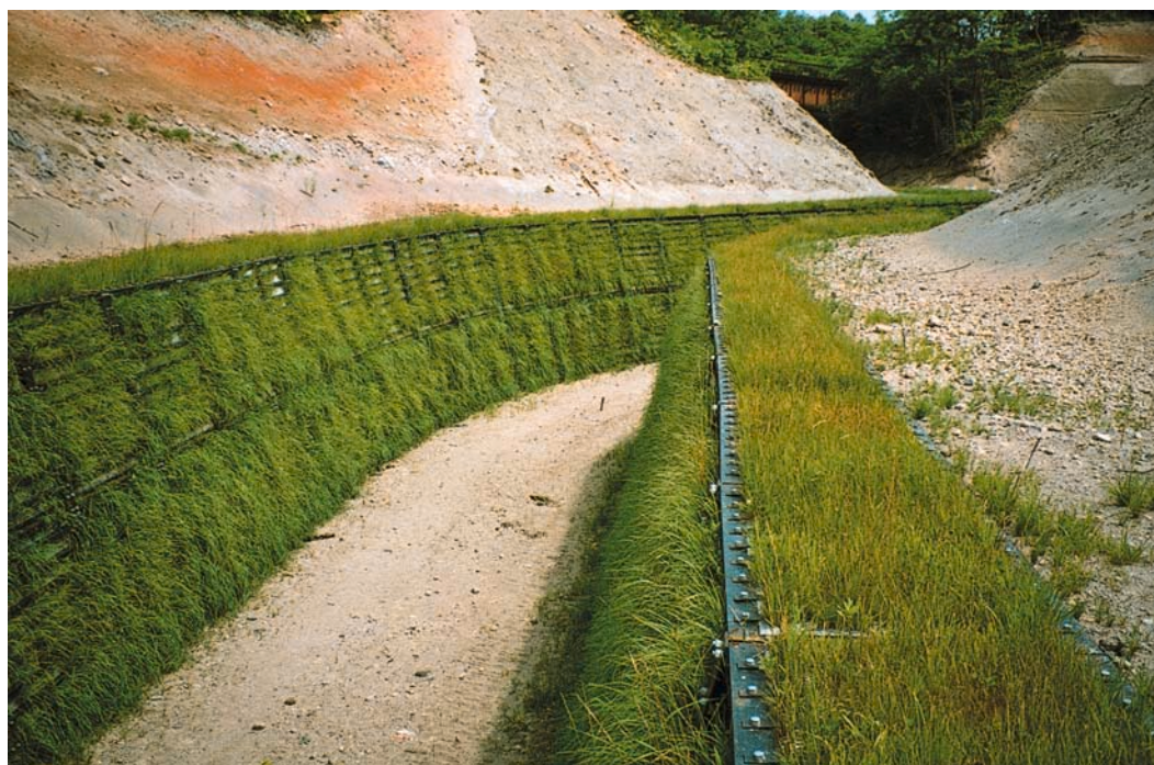
留の沢 壁高4m 平成8年[北海道]
