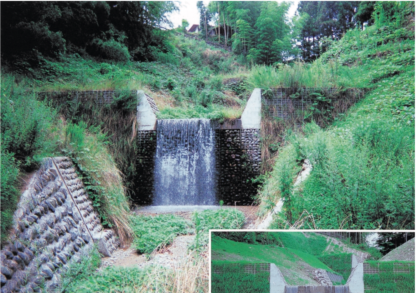
小洞口谷1、2号床固工 最近の状況 堤高5m 平成6年[岐阜県]
