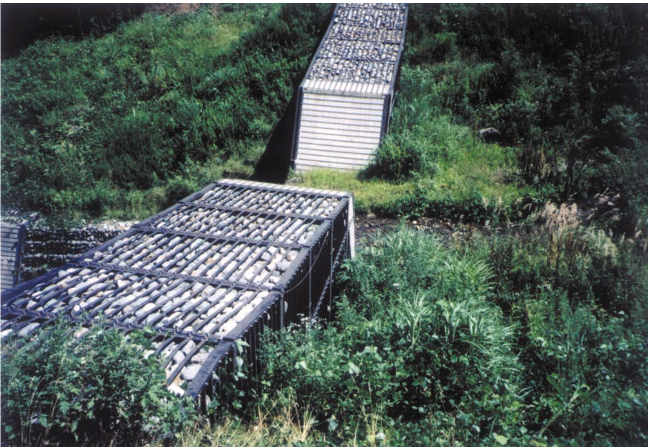
えん堤上流部が満砂となり堆砂域が安定して植生の回復が見られる 〔 長野県 〕
