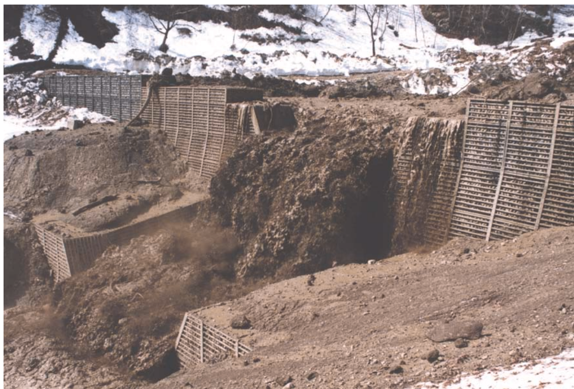
耳尾沢( 姫川水系 ) 平成12年4月融雪時に土石流が流下 堤高8m 平成8年設置[ 長野県 ]
