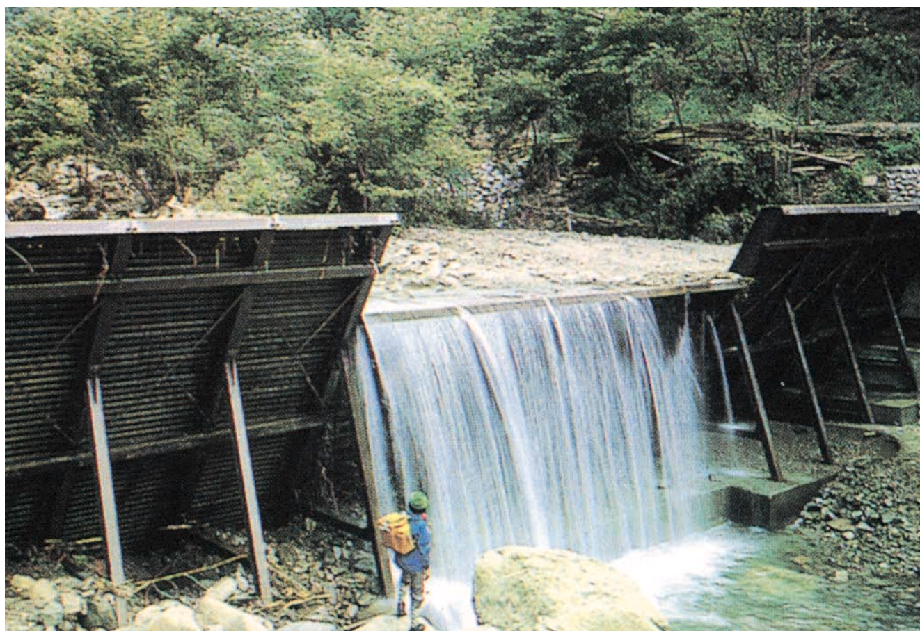
満砂で土砂を堆積・抑止し、植生の侵入が見られる(上下) 昭和47年[山形県]
