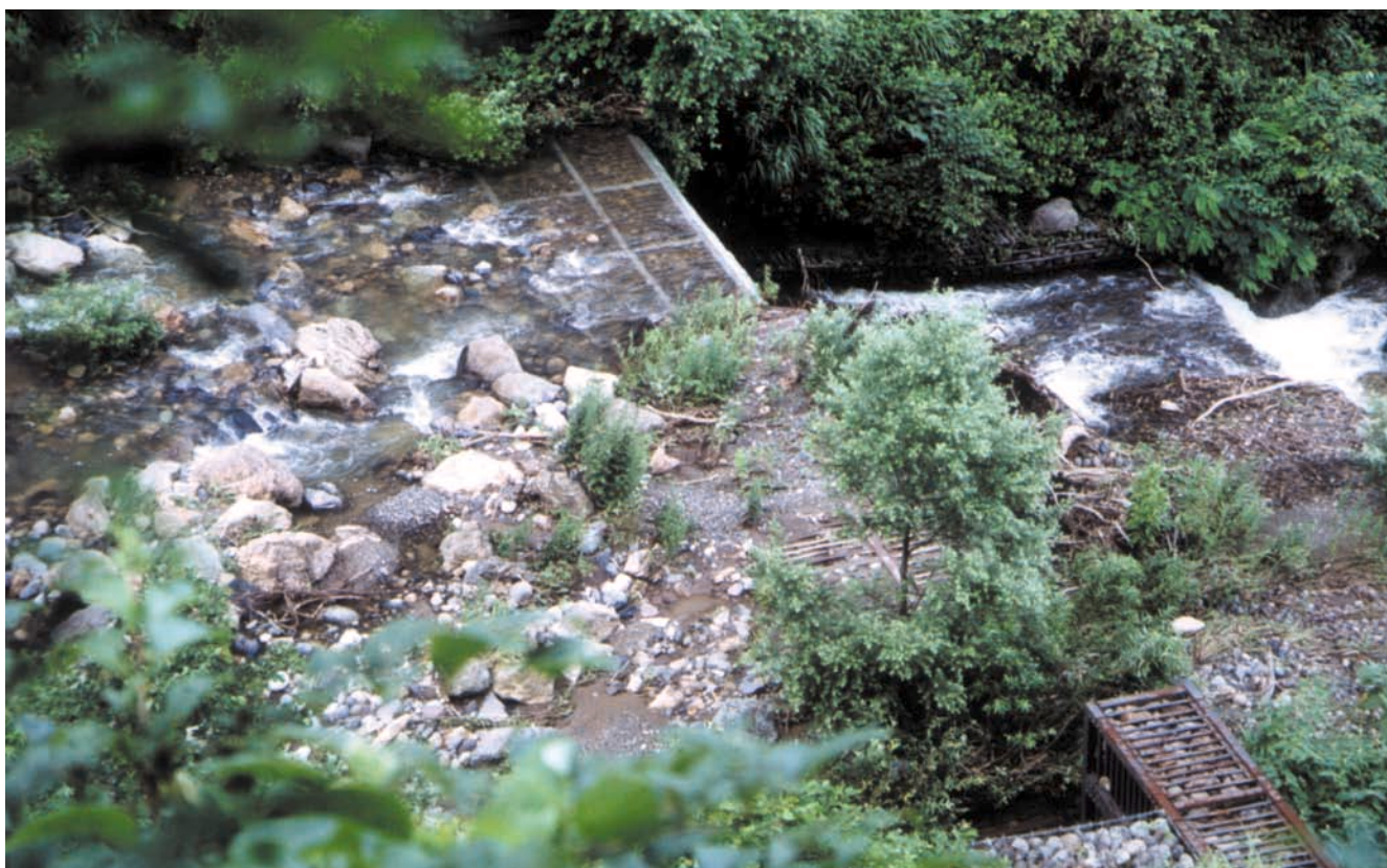
虫川 中流部のえん堤も満砂になっているが、土砂を調節している 堤高6m 昭和55年[新潟県]
