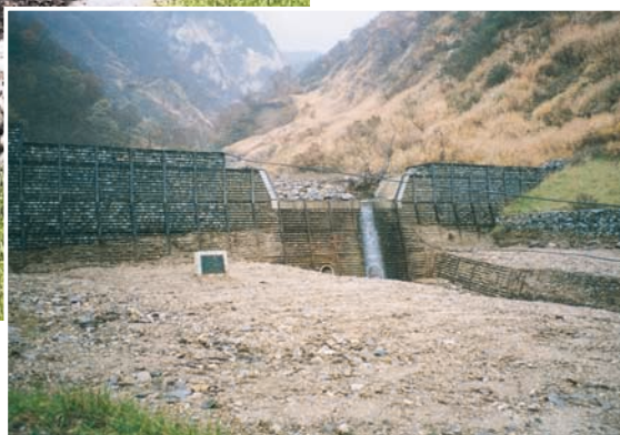
土石流捕捉後の上流の土砂堆積状況 平成8年撮影
