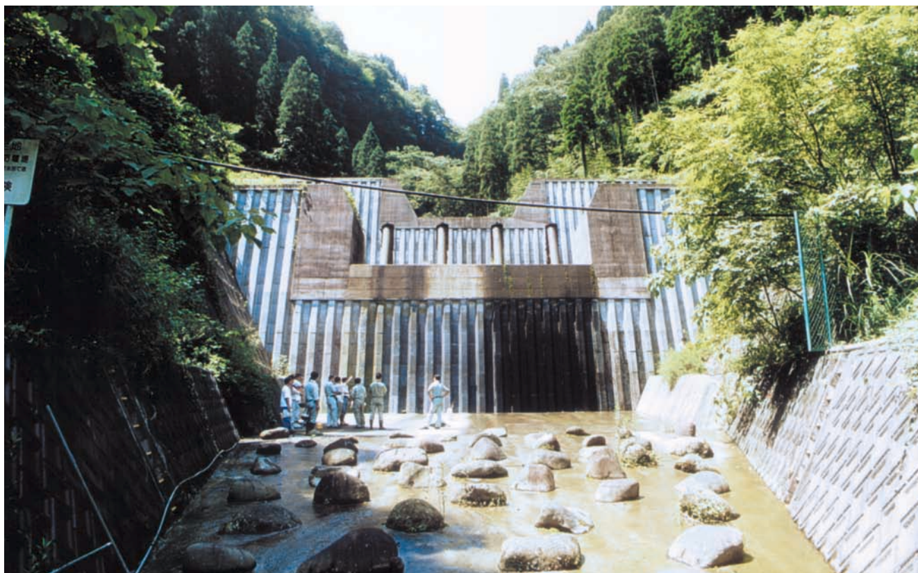
フラン谷川砂防えん堤 堤高12m、堤長58m 平成6年[熊本県]
