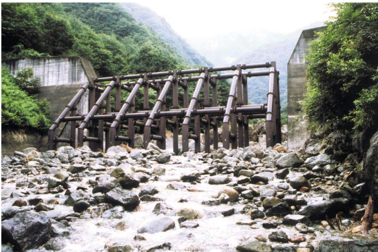
五十沢砂防えん堤 鋼製部高11m、全幅74m、鋼製部幅24m、水通し幅27m(198.5トン) 昭和62年[湯沢砂防工事事務所]
