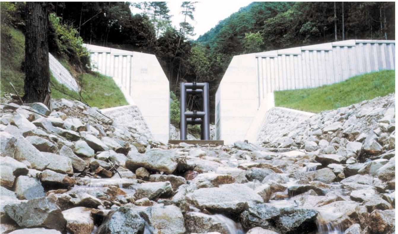
谷和川 河道整備と共に緊急対応で施工した 下流側より 鋼製部高6m 平成12年[広島県]
