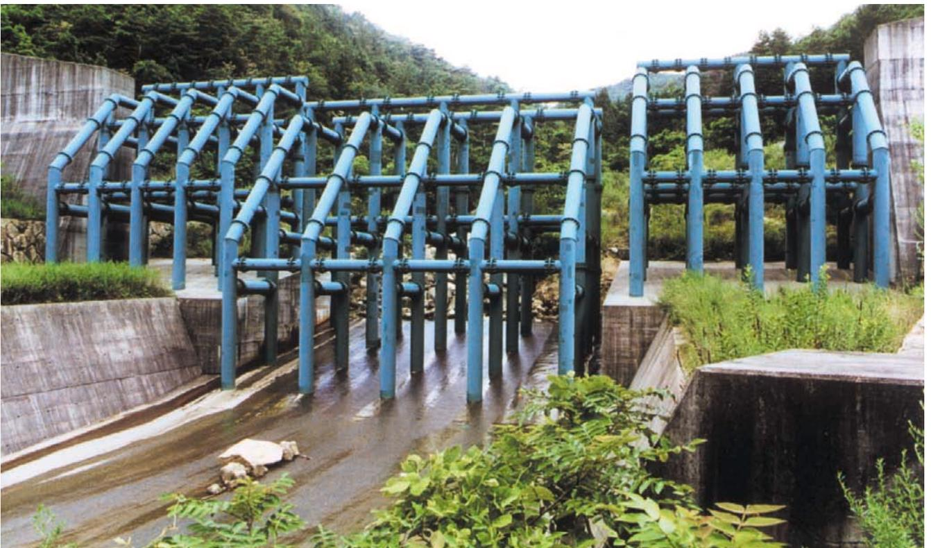
前飯谷川砂防えん堤 鋼製部高12m、全幅100m、鋼製部幅39.4m、水通し幅41.8m(340トン) 平成8年[ 広島県 ]
