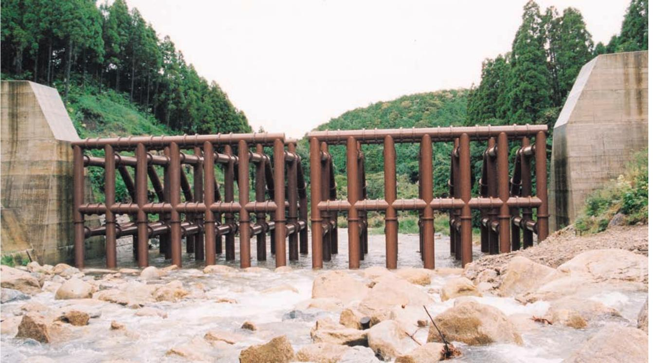
荒瀬川砂防えん堤 鋼製部高8m、全幅63m、鋼製部幅27.3m、水通し幅30m(219.8トン) 平成8年[ 鹿児島県 ]
