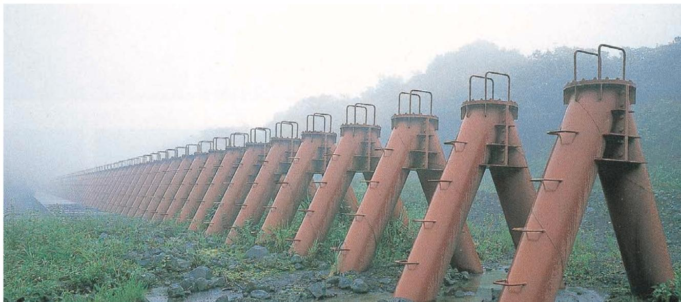
大沢川 樹林帯の保護と泥流抑制をはかるため設置 鋼製部高2m 昭和62年[富士砂防工事事務所]
