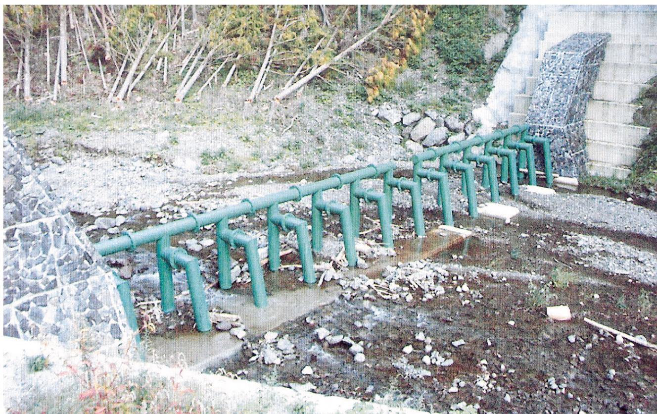
宮谷川3号流木止め 鋼製部高3m、鋼製部幅24m、水通し幅25m(21.2トン)平成11年[奈良県]
