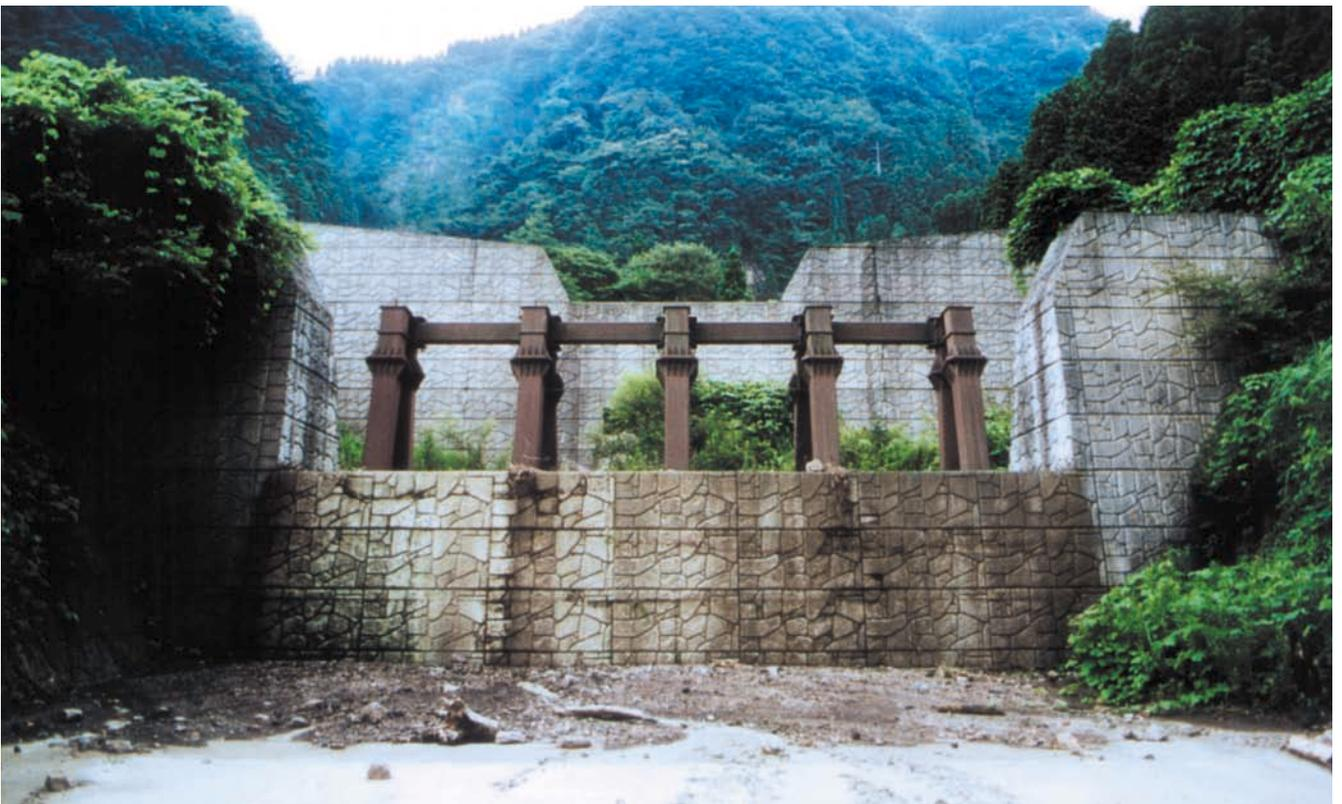
平保の木川流木止工 鋼製部高3m 平成3年[熊本県]
