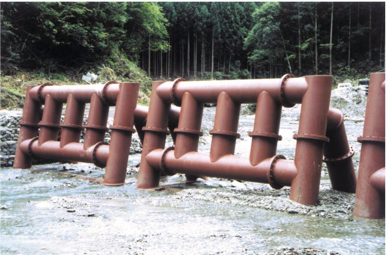
藤川谷川(堆砂域に緊急設置) スリット高3m、全高5m 平成10年度[徳島県]
