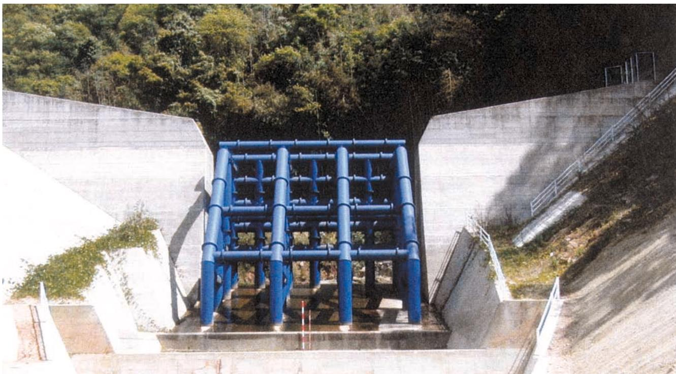
三迫川砂防えん堤 鋼製高8m、全幅58m、鋼製部幅9.6m、水通し幅12m(111.4トン) 平成10年[広島県]
