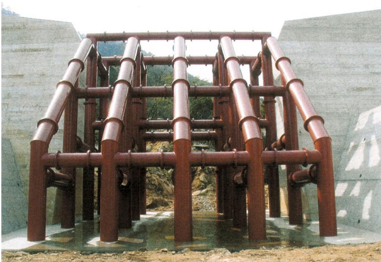
八幡川砂防えん堤 鋼製部高10.5m、全幅75m、鋼製部幅10m、水通し幅12m(113.9トン) 平成12年[広島県]
