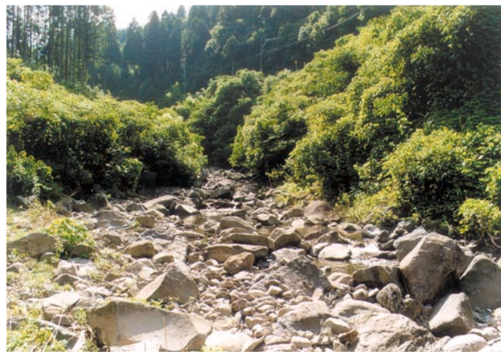
上流部の堆積状況
