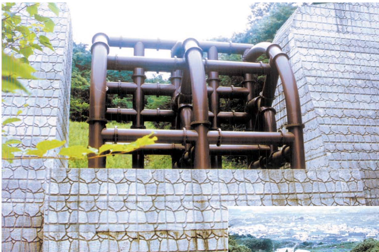
百合谷川に設置した曲線を有する最下流タイプの砂防えん堤 鋼製部高8m、全幅48m、鋼製部幅8m、水通し幅11m(72.8トン) 平成10年[和歌山県]
