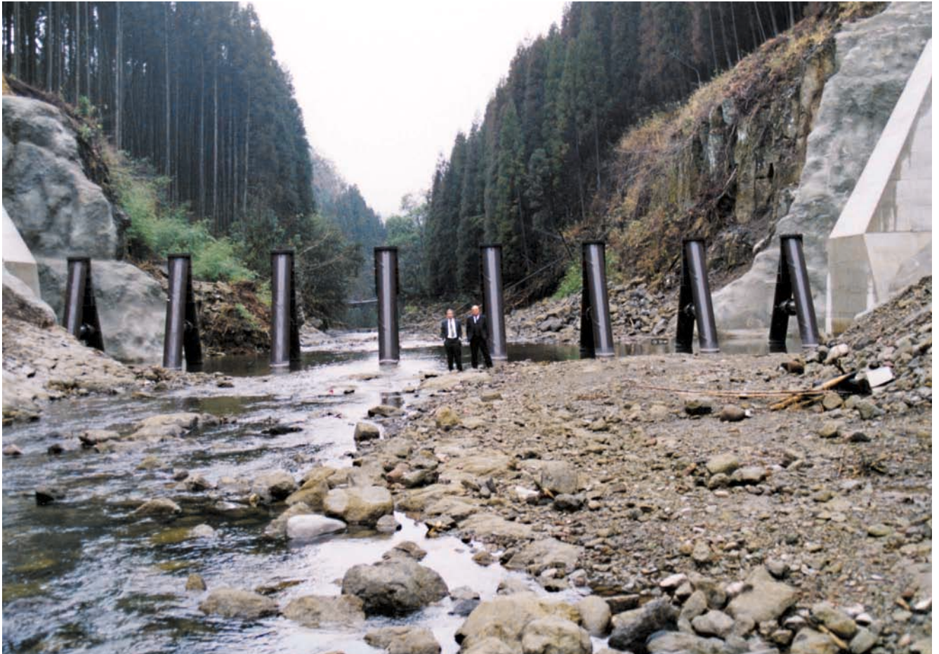
北里川 自然の流れを阻害しない、土砂の堆積は自然の流れによる 鋼製部高4m 平成5年[ 熊本県 ]
