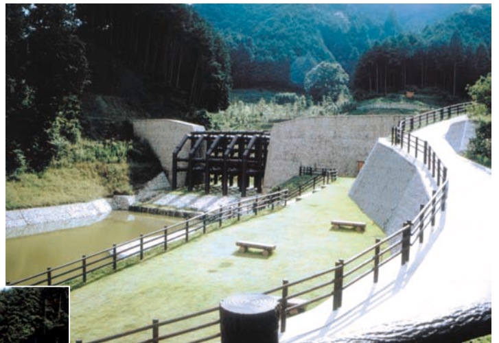
直下流域には基幹道路と住宅街が集合しているため、最下流タイプ格子形が設置された
