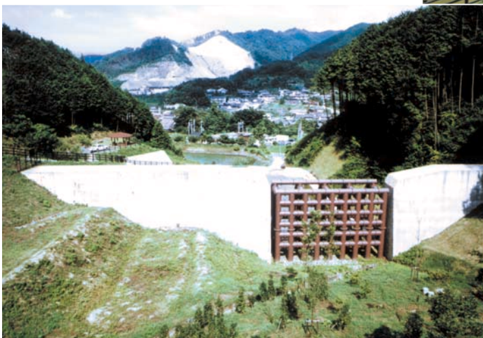
直下流域には基幹道路と住宅街が集合しているため、最下流タイプ格子形が設置された
