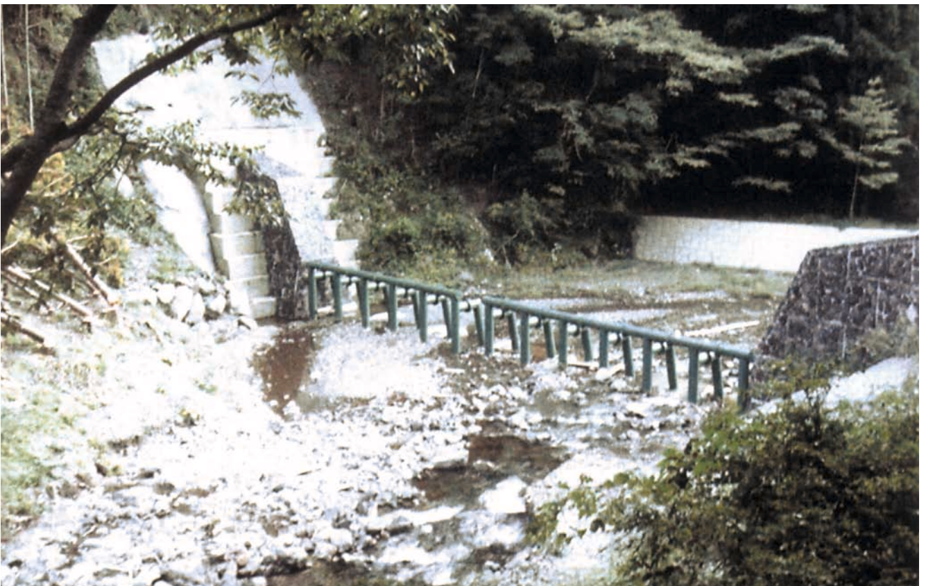
宮谷川3号流木止工 鋼製部高3m、鋼製部幅24m、水通し幅25m(21.2トン) 平成11年[奈良県]
