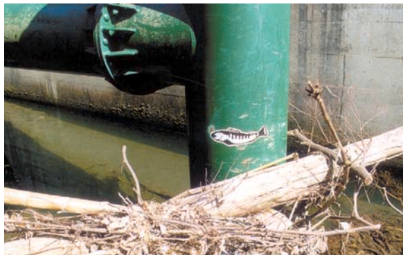
鹿狩川砂防えん堤 鋼製部高8m、全幅51m、鋼製部幅16.8m、水通し幅20m(105トン) 平成6年[福岡県]
