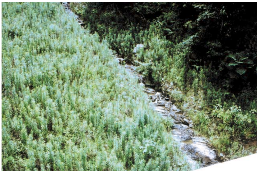
上流域に荒廃が見られ土石流危険渓流に指定されている
