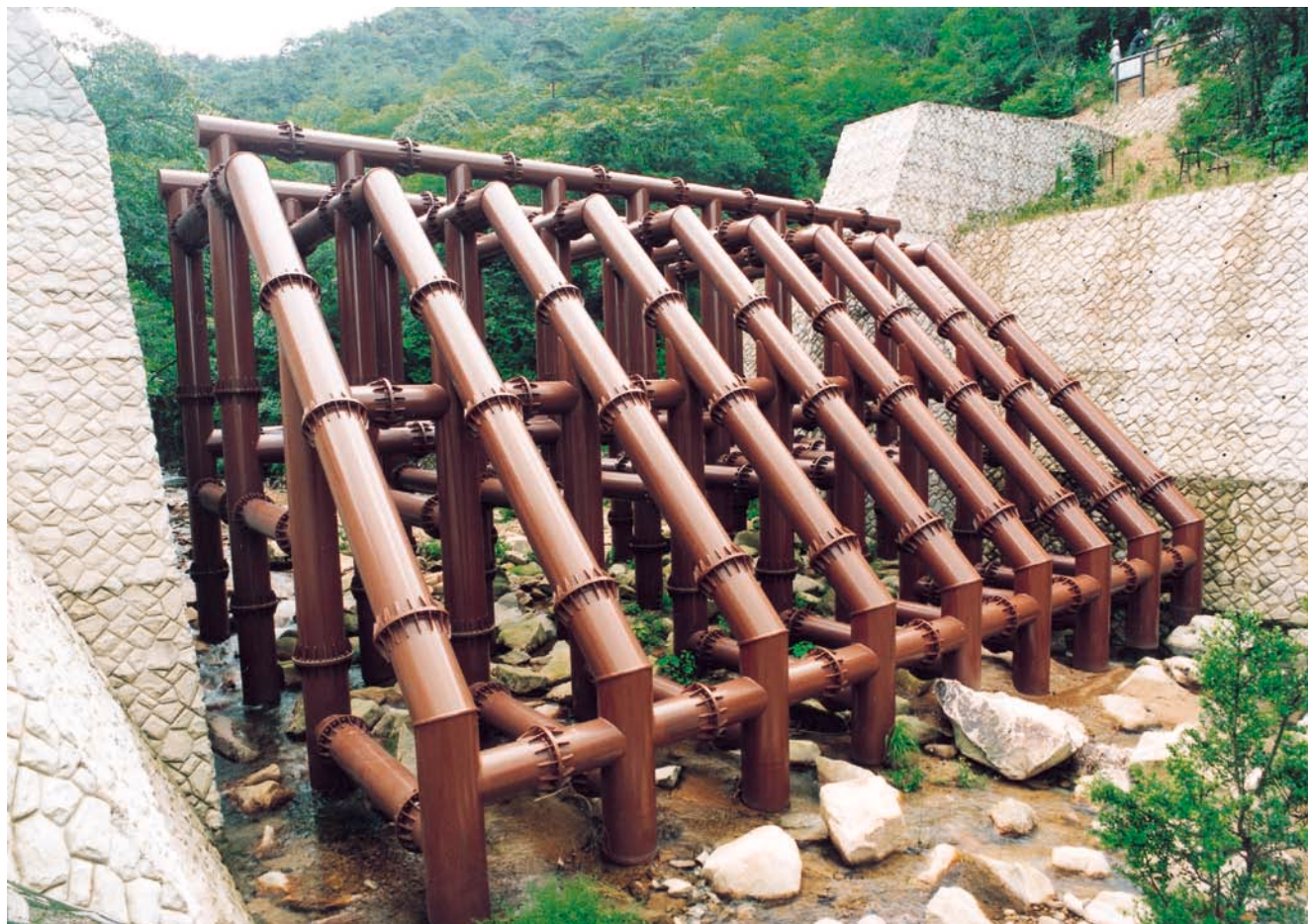
鋼製部高10.5m、全幅35m、鋼製部幅16.8m、水通し幅20m(186.8トン) 平成5年
