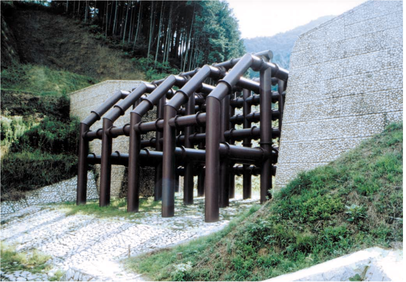
公園内では自然を学び体験できるゾーンが設置され、環境にも配慮された格子形鋼製砂防えん堤で保全対策が行われている
