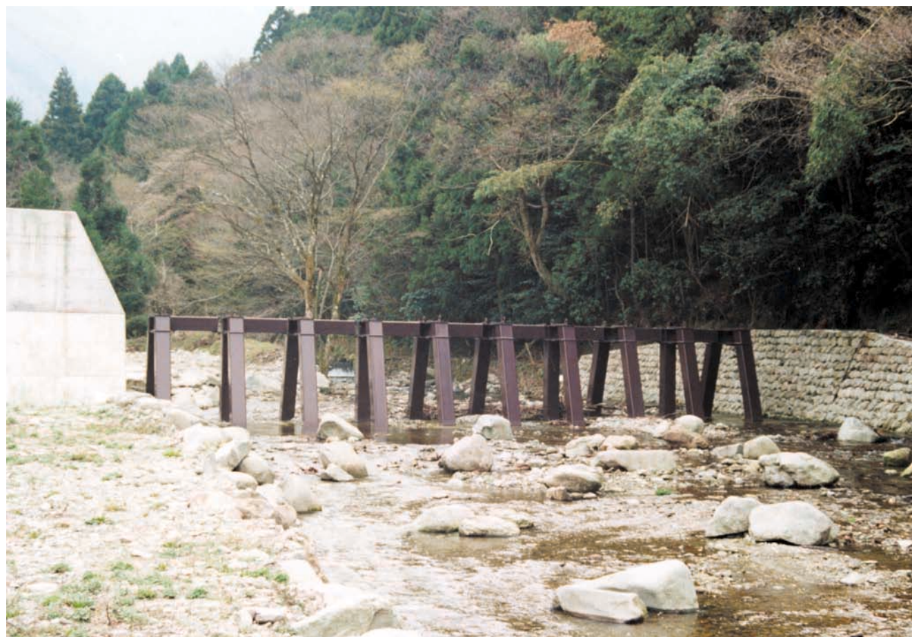
清水谷川 鋼製部高3m[倉吉工事事務所]
