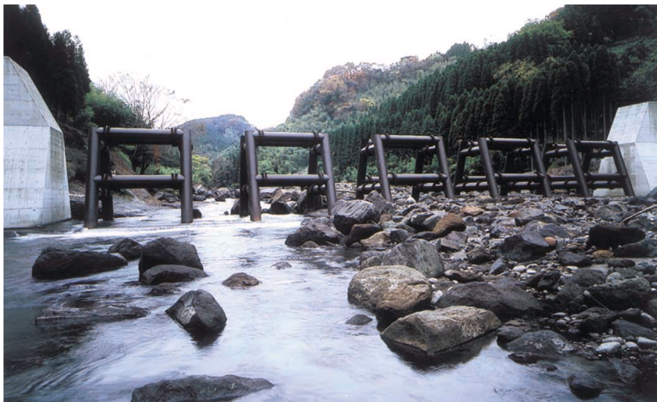
鋼製部高5m 平成5年[大分県]
