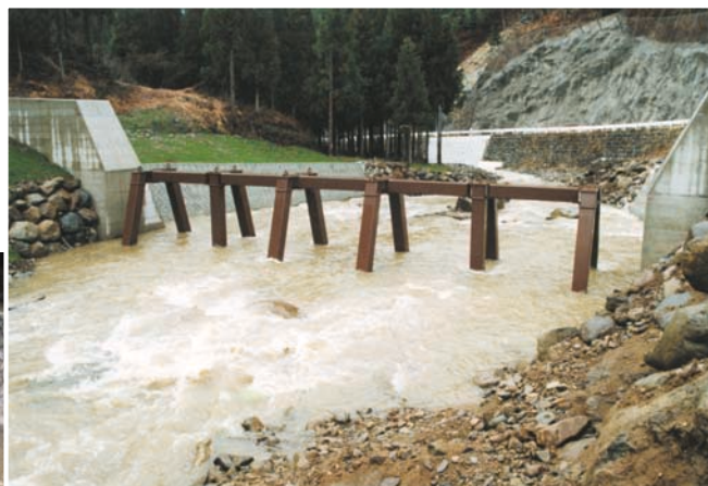
殿川 鋼製部高3m 平成11年度[岐阜県]
