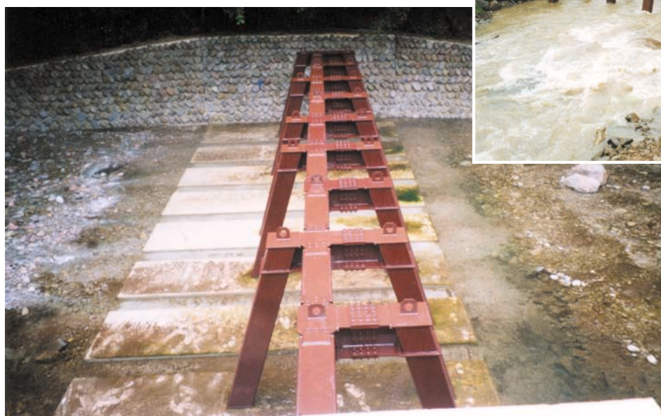
清水谷川 滞筋固定で魚道を確保 鋼製部高3m 平成11年度[倉吉工事事務所]
