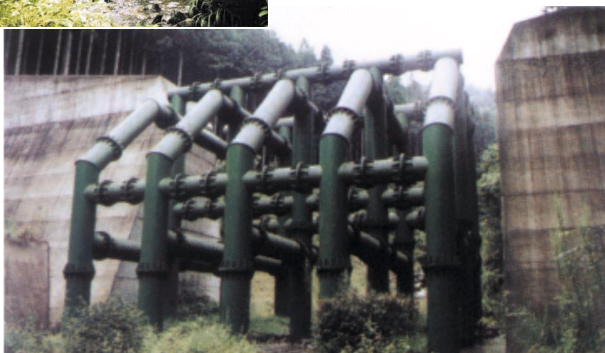
坊の奥川砂防えん堤 鋼製部高10.5m、鋼製部幅8.8m、水通し幅11m(74.1トン)平成6年[兵庫県]
