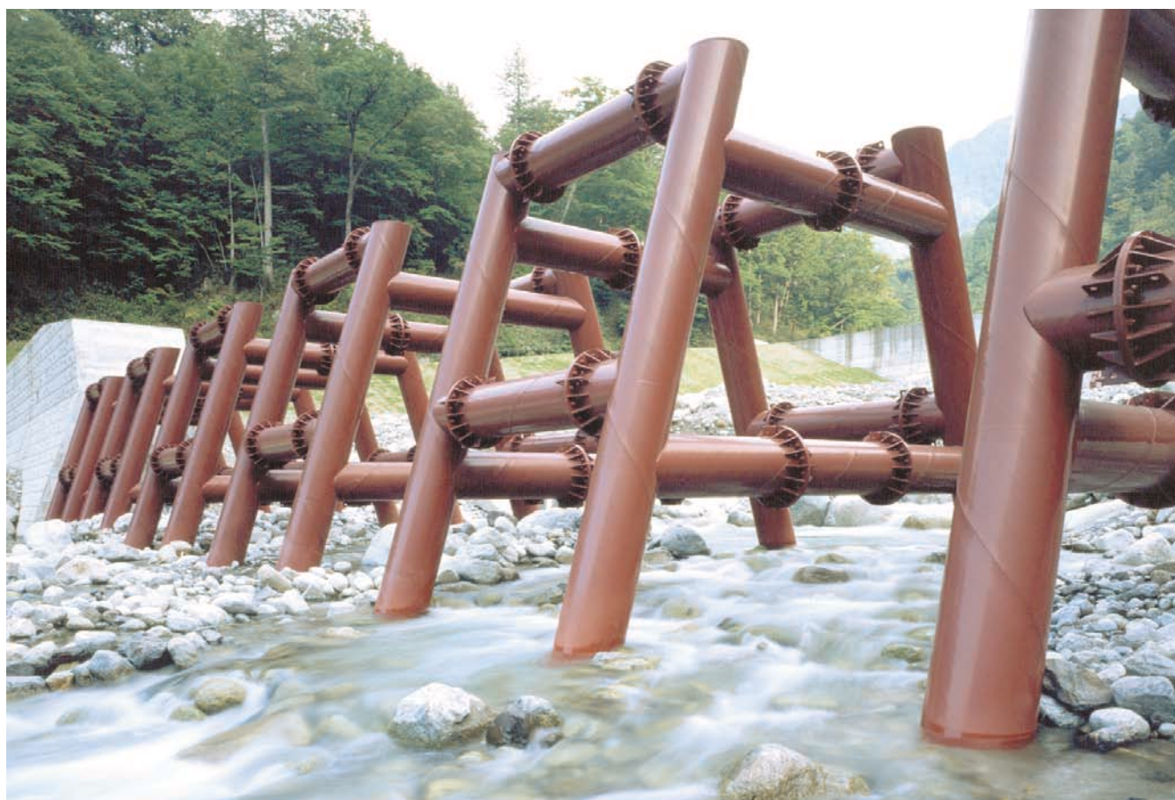
滑川 鋼製部高6m 平成12年[多治見工事事務所]
