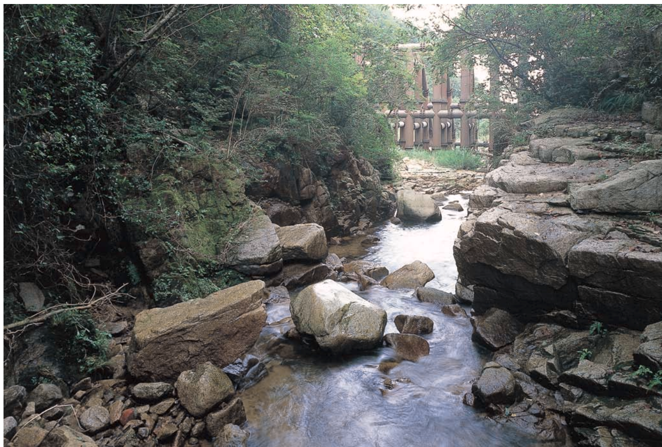
鷹尾第2えん堤 溪流環境保全に配慮した砂防えん堤を設置 [六甲砂防工事事務所]
