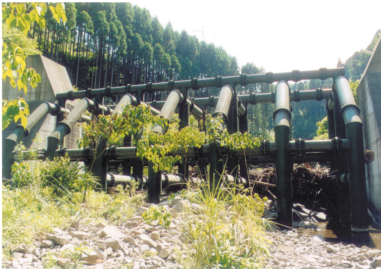
鹿狩川砂防えん堤 鋼製部高8m、全幅51m、鋼製部幅16.8m、水通し幅20m(105トン) 平成6年[福岡県]
