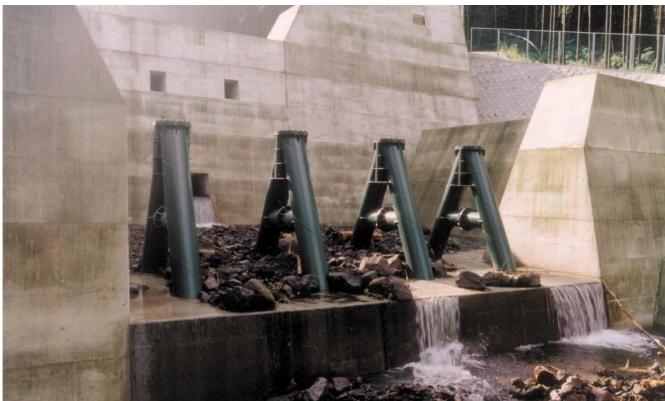
塩井川 鋼製部高3m スリットの間を小さな礫が流れている 平成3年[熊本県]
