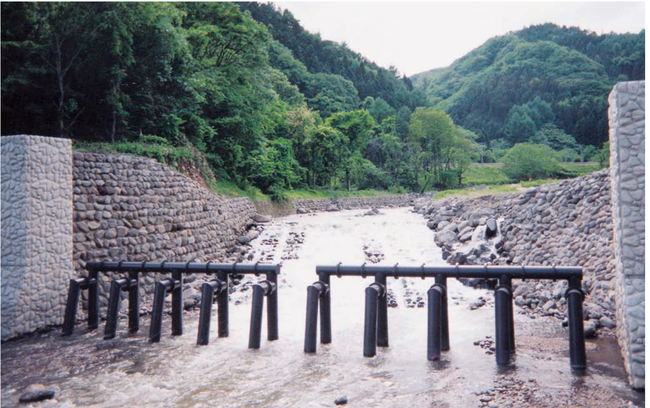
鳥居川流木止工 鋼製部高4m、鋼製部幅22.5m、水通し幅25.7m(358トン) 平成9年[長野県]
