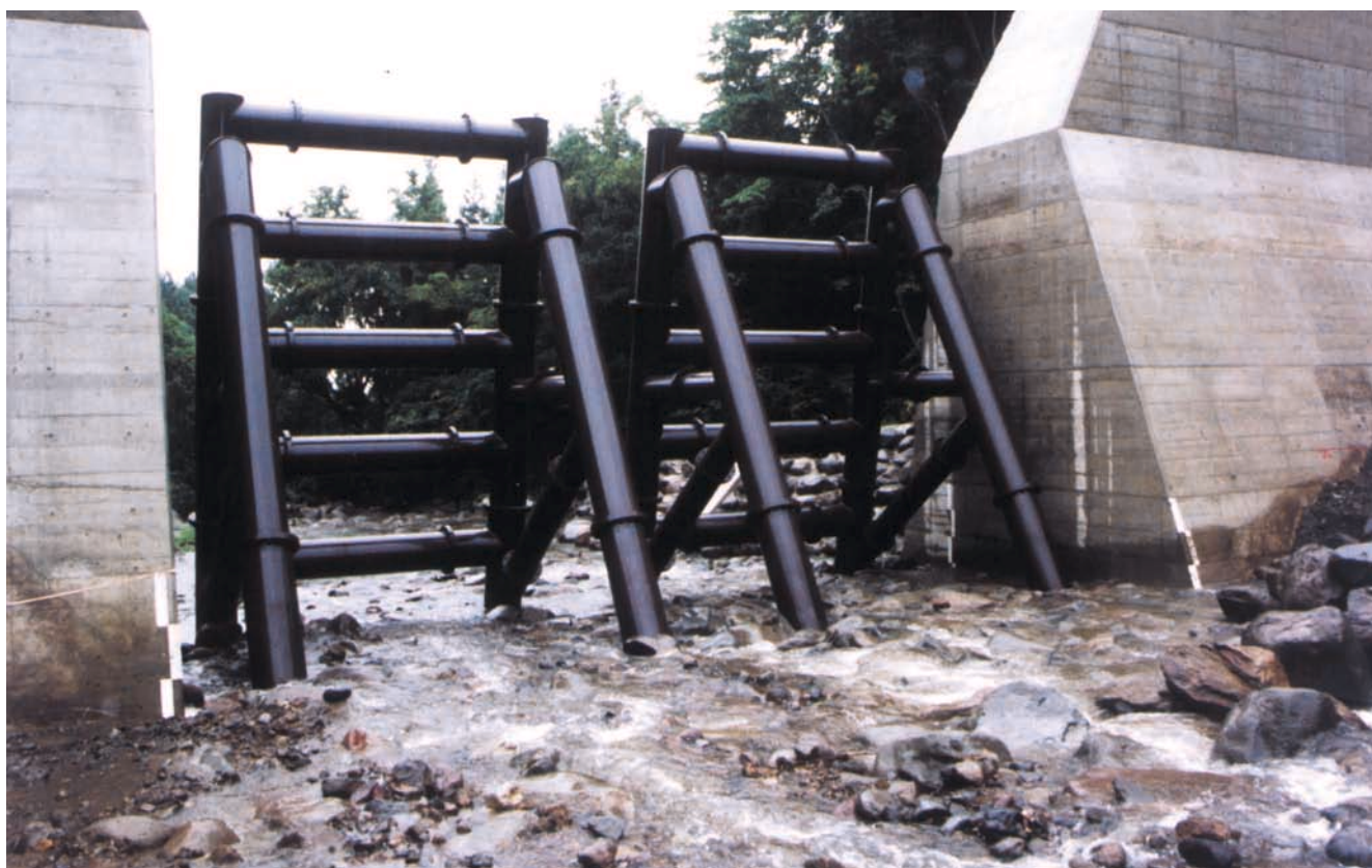
運上川 上流側 鋼製部高8m、全高10m 平成11年度 [長野県]
