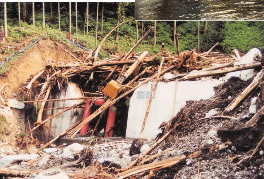
流木と礫等を捕捉 鋼製部高3m 平成5年[ 大分県 ]
