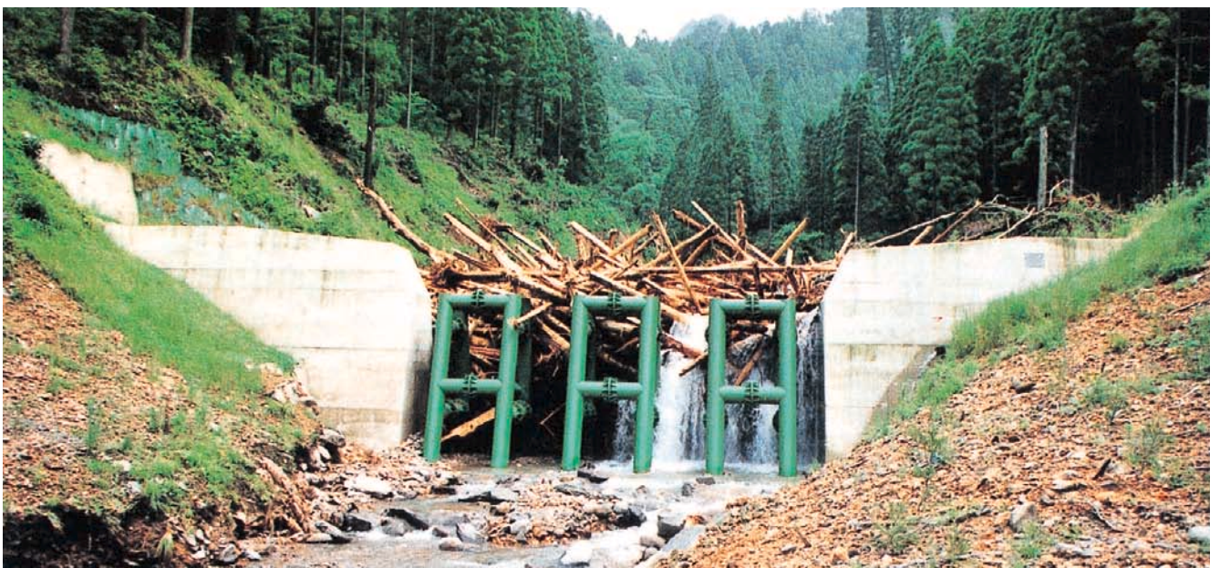
流木捕捉後 鋼製部高5m 平成3年[大分県]
