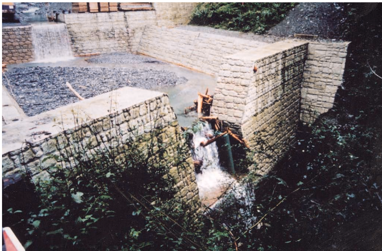
越流してきた流木を副堤で捕捉
