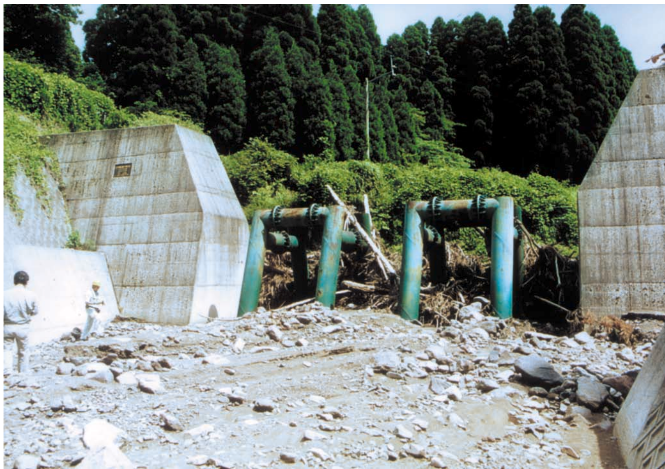
古恵川 古恵川上流部に設置した鋼製スリットえん堤B型で礫、流木を捕捉 平成4年[ 熊本県 ]
