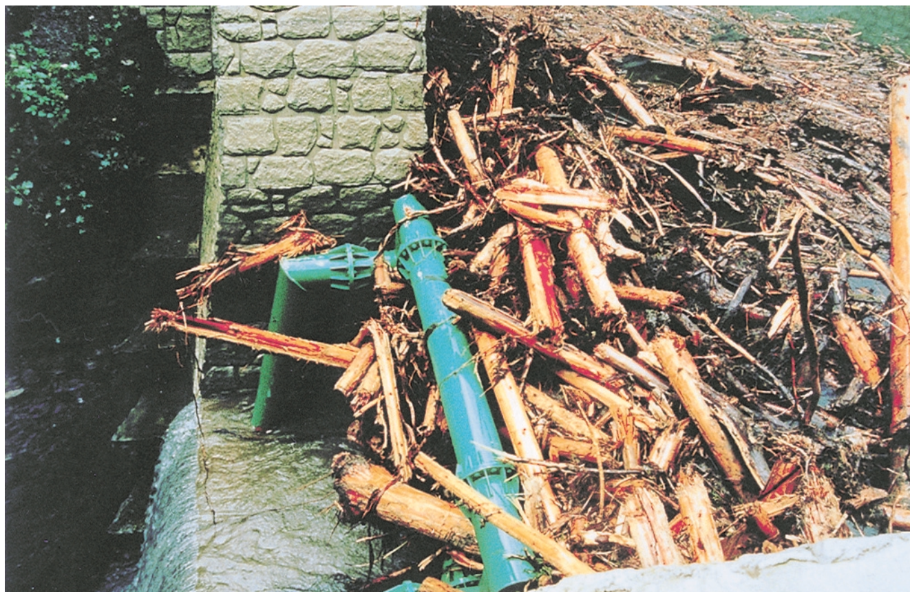
モチゴヤ谷流木止め工 鋼製部高2m、鋼製部幅4m、水通し幅5m(3.4トン)平成4年[ 四国山地砂防工事事務所 ]
