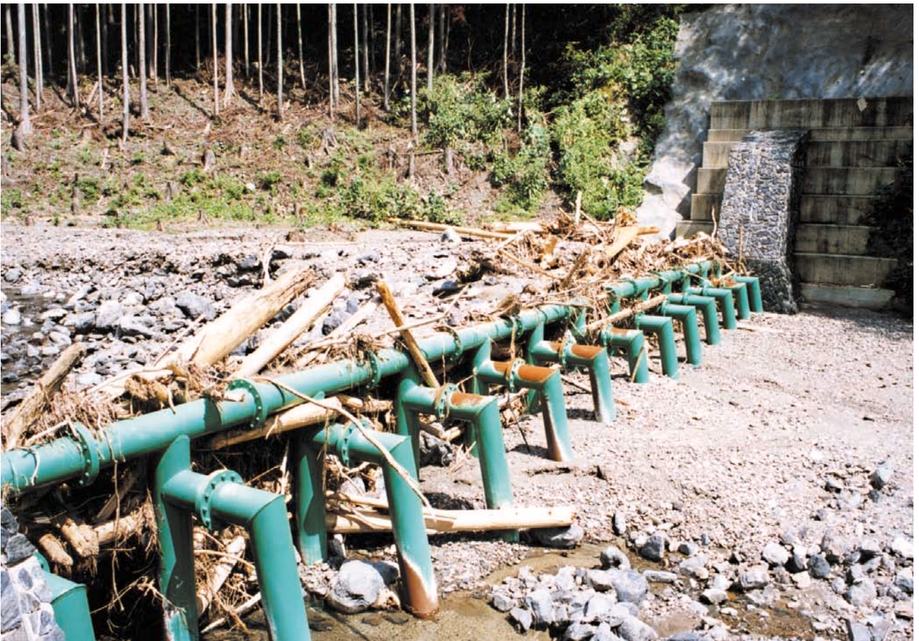
宮谷川3号流木止工 鋼製部高3m、鋼製部幅24m、水通し幅25m(21.2トン) 平成11年設置 平成13年撮影[奈良県] 土砂、流木を捕捉した鋼製h型スリット
