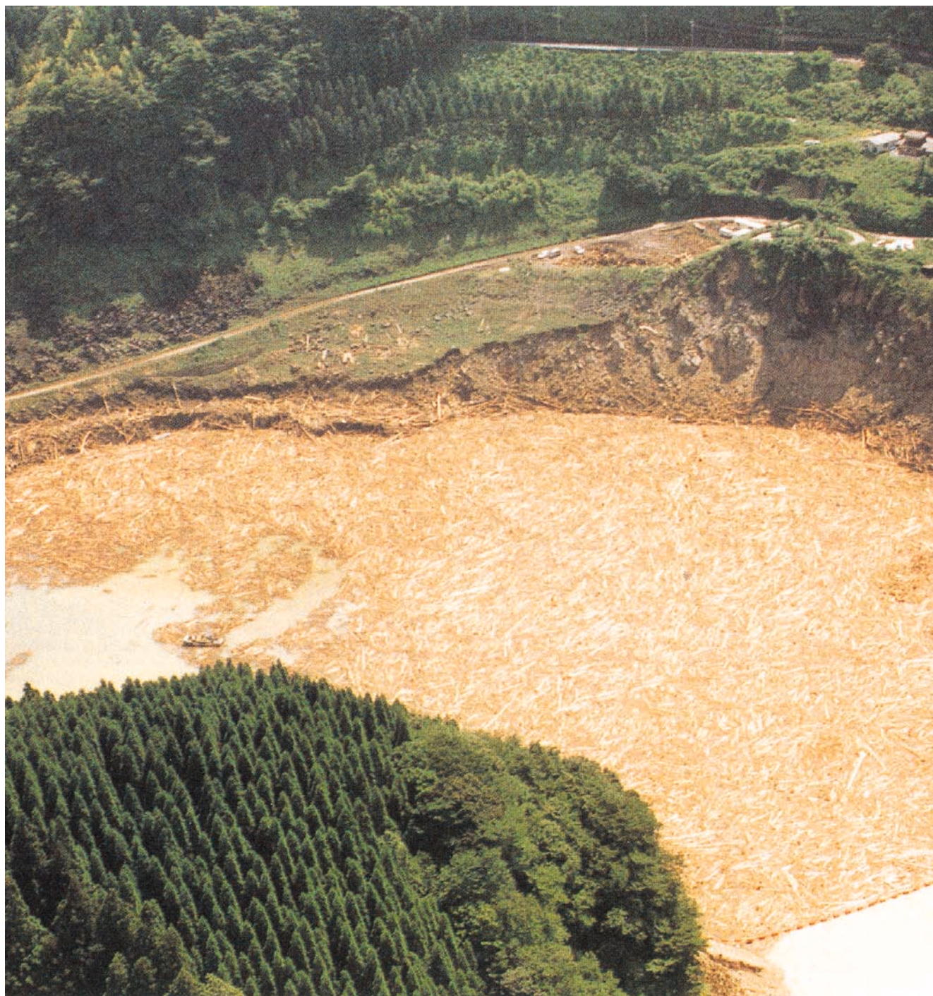
平成5年6月の集中豪雨により発生した流木が松原ダムに流入した〔大分県〕
