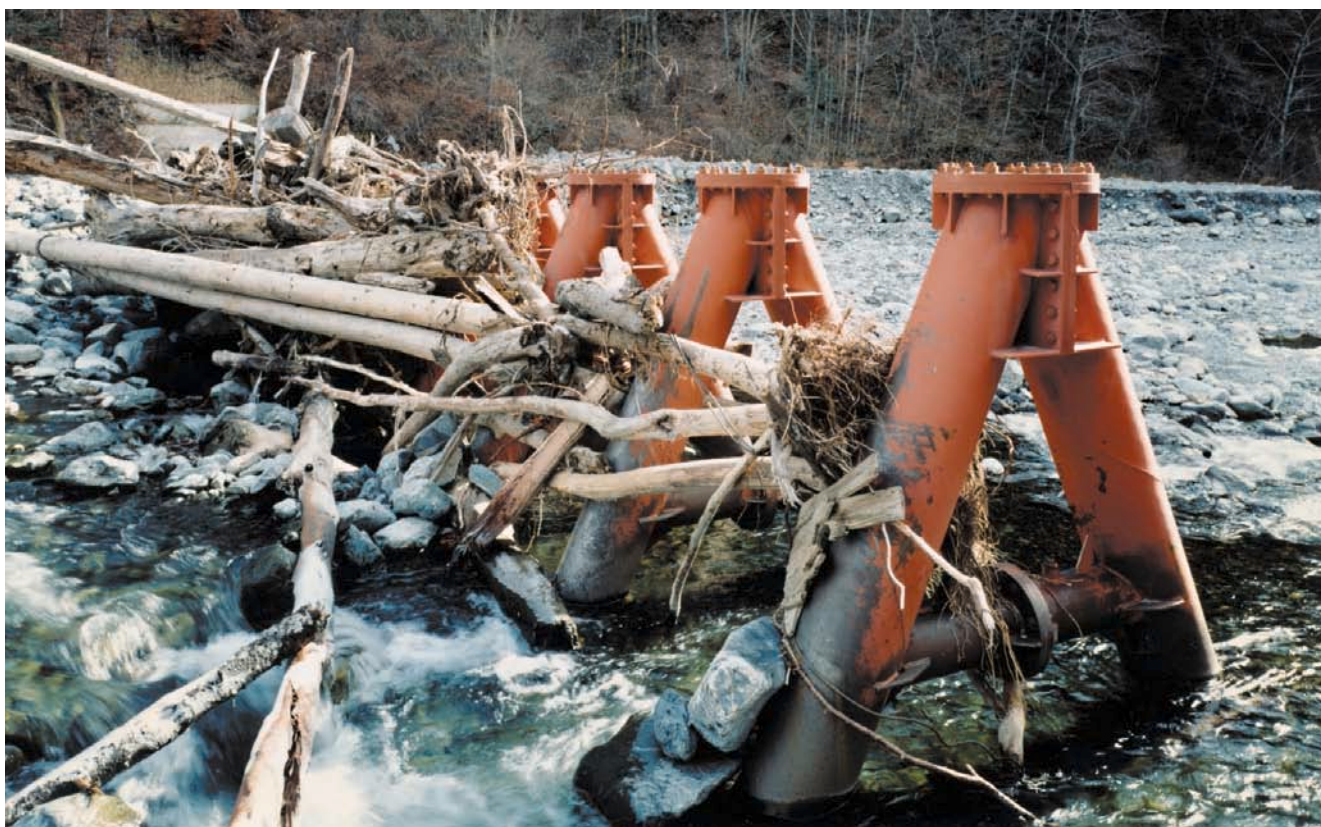
三峯川 伊那谷の長大、太径の流木捕捉 鋼製部高3m[ 長野県 ]
