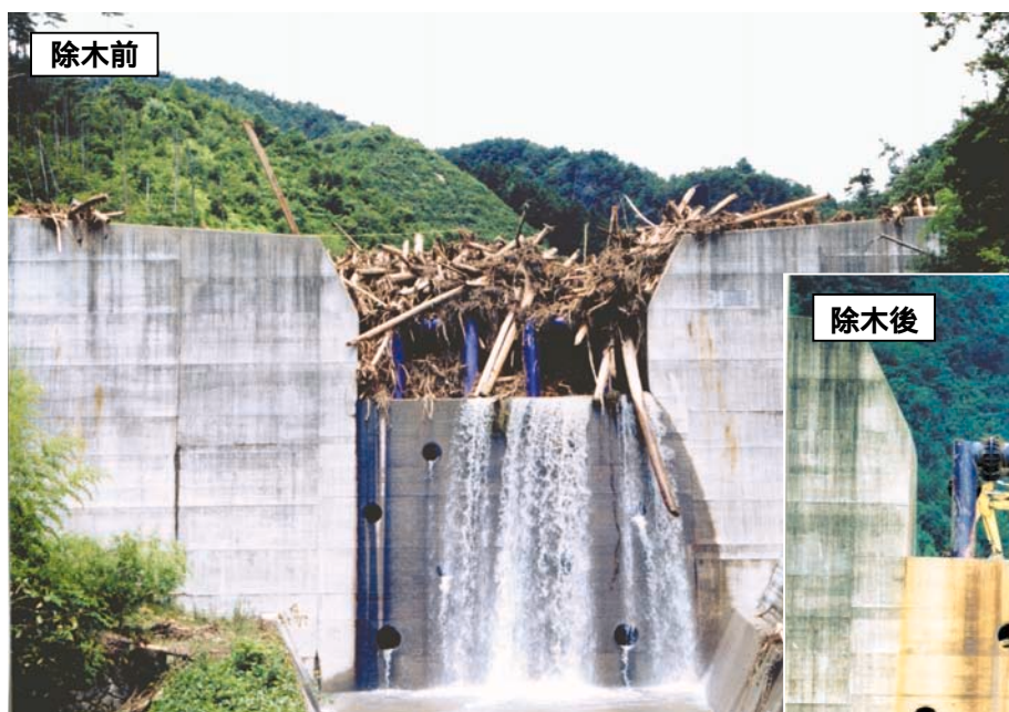
荒谷川 流木を捕捉し効果を発揮した 鋼製部高3m 平成11年[ 広島県 ]
