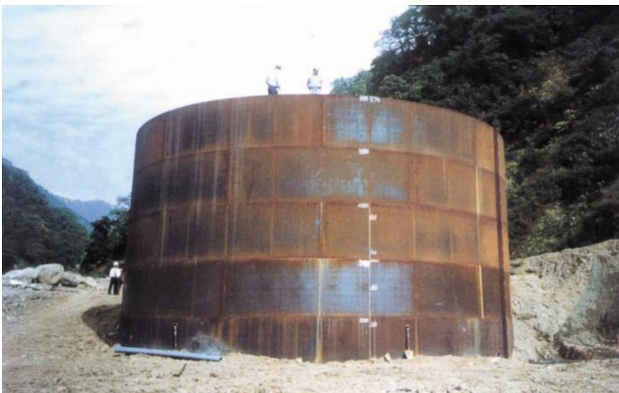
土谷川 鋼製高10m、直径14m 平成9年[長野県]
