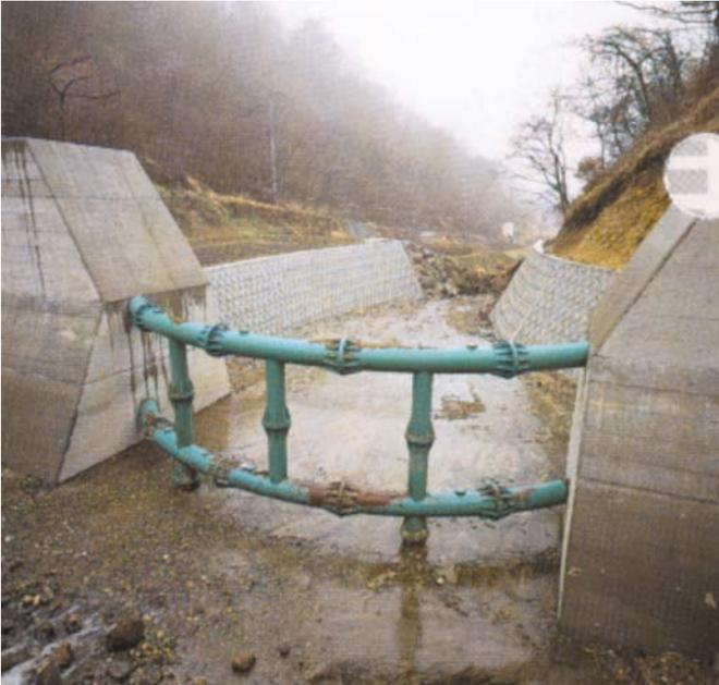
藤蔵川(上流側) 鋼製部高3m、鋼製長12m[大分県]
