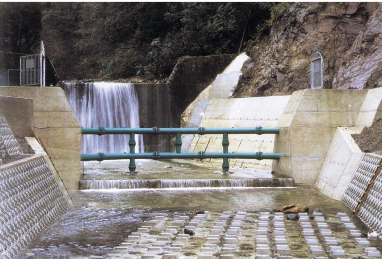
藤蔵川(下流側) 鋼製部高3m、鋼製長12m[大分県]
