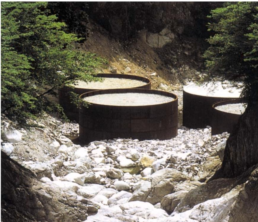
与田切川 鋼製高10m、直径14m 平成9年[天竜川上流工事事務所]
