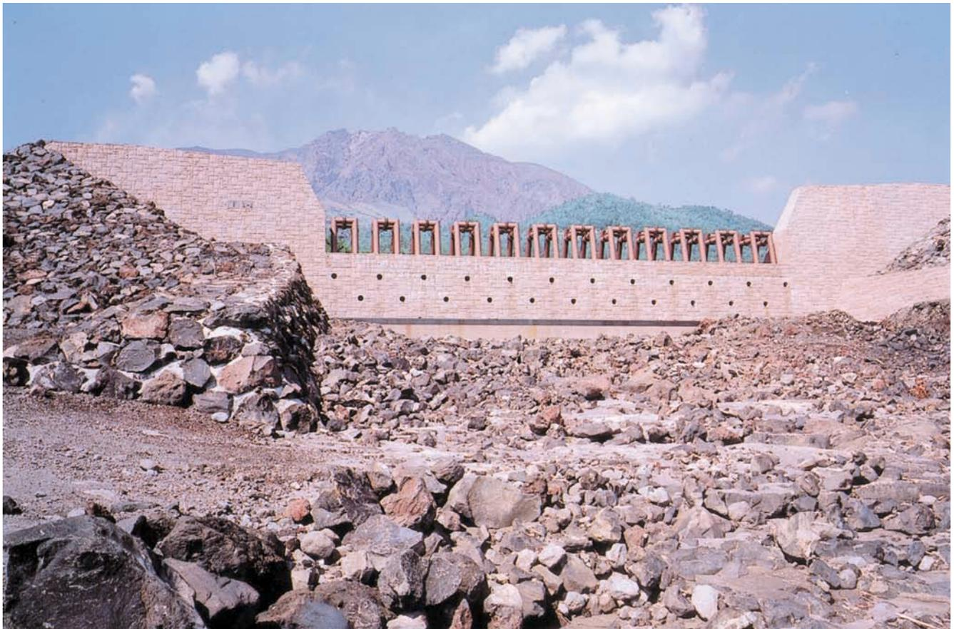
引ノ平川 鋼製部高4m 平成8年[大隅工事事務所]
