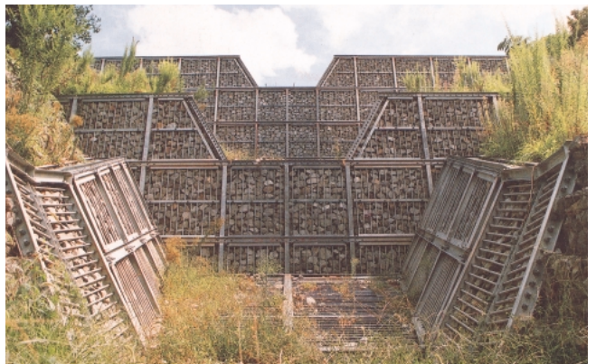
枠えん堤(鋼製箱枠) [和歌山県]
