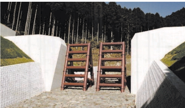
鋼製L型スリットえん堤 [福岡県]
