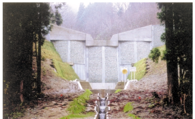
鋼矢板セグメントセルえん堤 [山形県]
