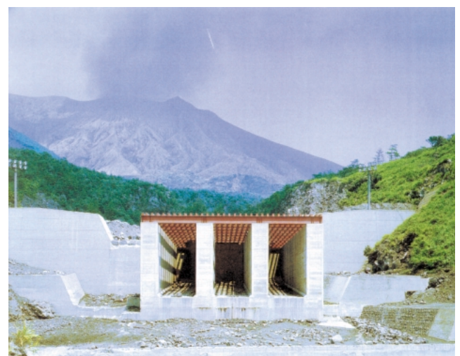
底面水抜きスクリーンえん堤(土石流ブレーカー) 【大隅工事事務所】
