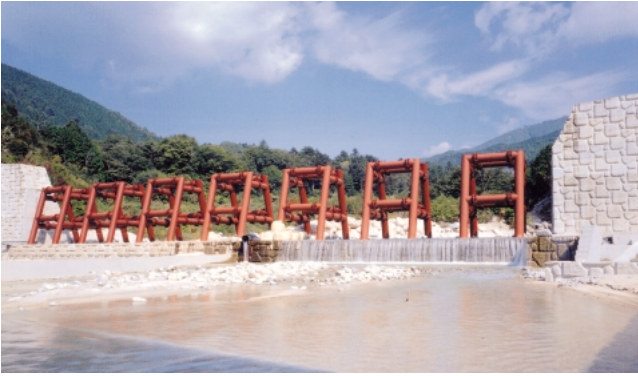
鋼製スリットえん堤B型 [多治見工事事務所]
