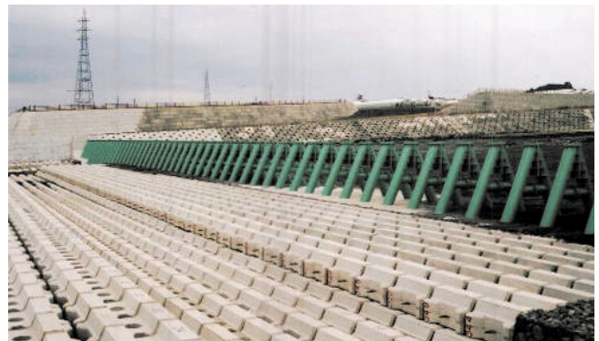
鋼製スリットえん堤A型 [雲仙復興工事事務所]
