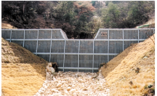
枠えん堤(鋼製続枠) [六甲砂防工事事務所]
