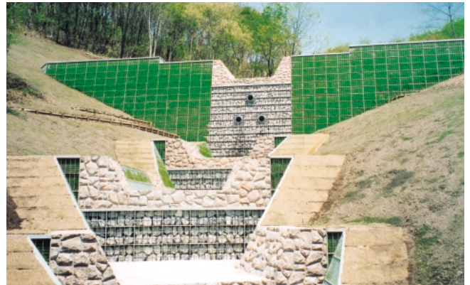
ダブルウォールえん堤 [福島県]
