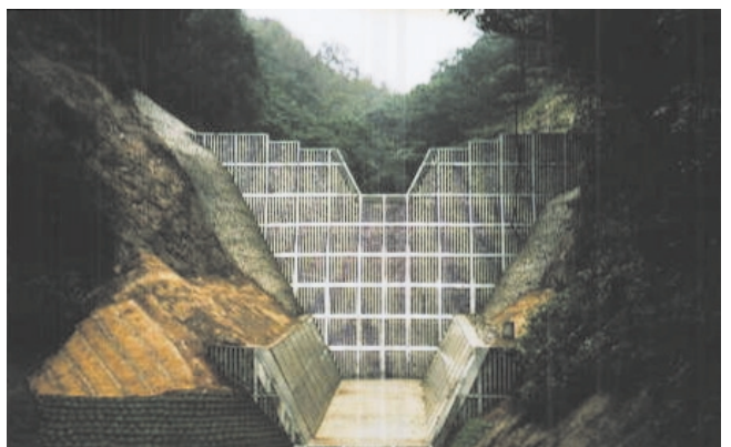
枠えん堤(鋼製組枠) [兵庫県]
