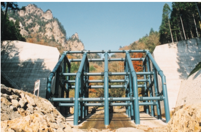
格子形鋼製砂防えん堤 [兵庫県]
