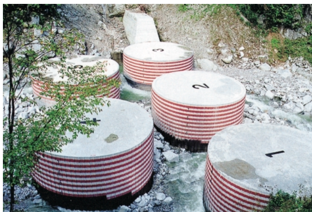
鋼矢板セグメントセルえん堤 [天竜川上流工事事務所]
