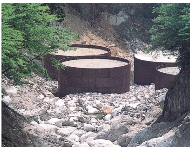
鋼板セグメントセルえん堤 [天竜川上流工事事務所]
