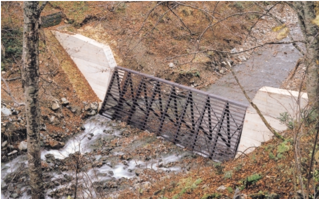
バットレススクリーンえん堤(鋼製えん堤) [山形県]
