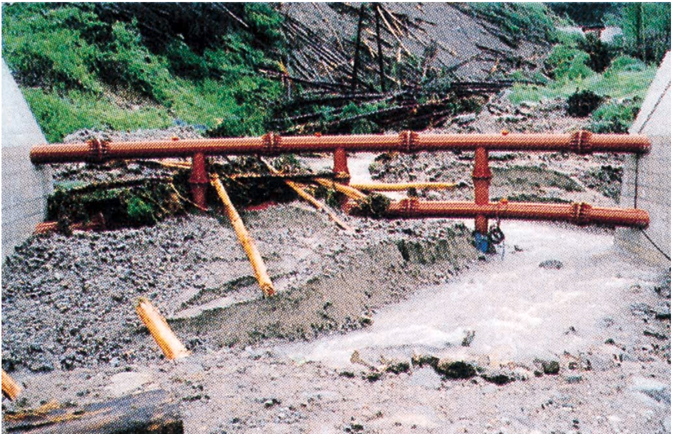
折元川 鋼製部高3m、鋼製長10m 【熊本県】
