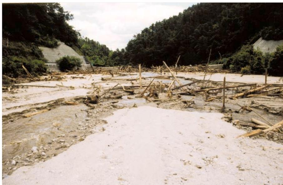
平成11年6月29日の豪雨により、広島県佐伯区荒谷川では、約4,500m<sup>3</sup>もの土砂を捕捉した。土石流の中には多くの流木が含まれており、鋼製スリットえん堤B型の設置により流木を捕捉し下流域の被害を最小限に抑えた。
