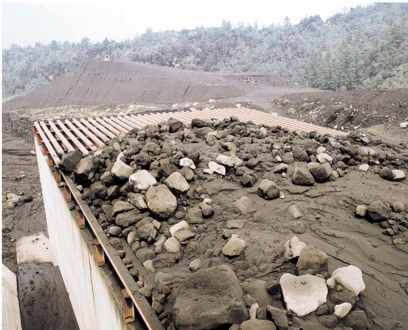
野尻川 土石流を捕捉 平成2年[大隅工事事務所]
