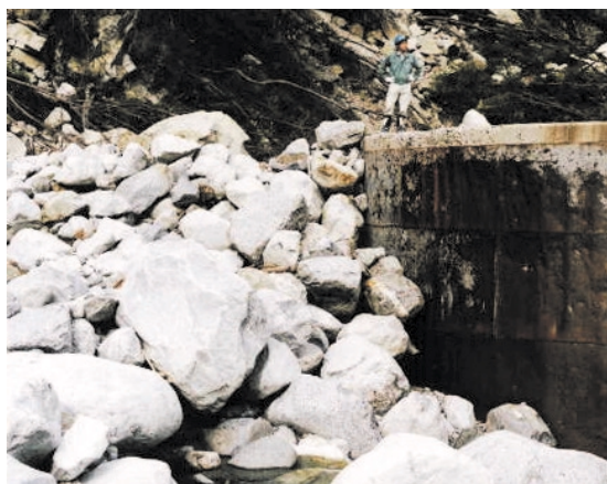
与田切川最上流部に設置された鋼製セグメントセルえん堤〔天竜川上流工事事務所〕
