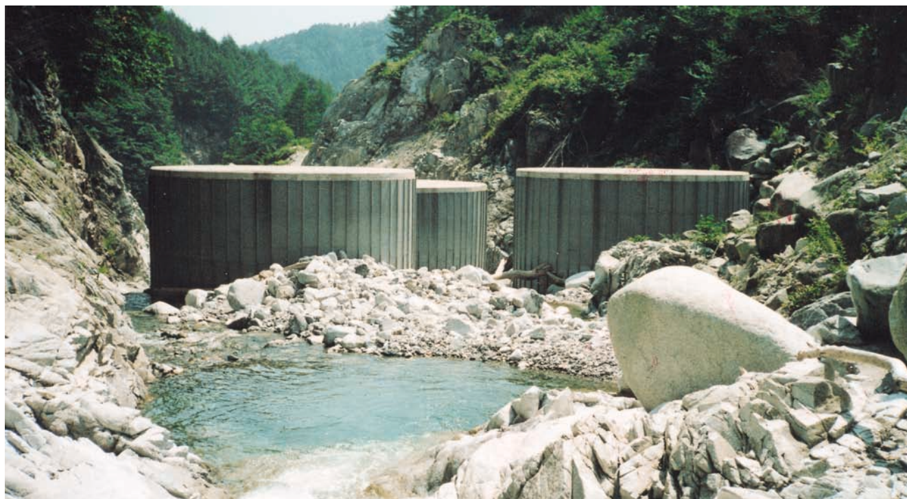
与田切川最上流部に設置された鋼製セグメントセルえん堤〔天竜川上流工事事務所〕
