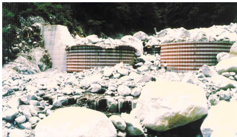
与田切川最上流部に設置された鋼製セグメントセルえん堤〔天竜川上流工事事務所〕
