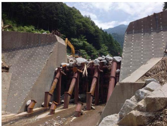
写真-3.1 土石流により上部1/3が流出した堰堤
