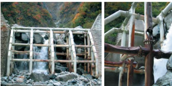
写真-5 一部の部材が破損したが問題無く土石流を捕捉した事例
