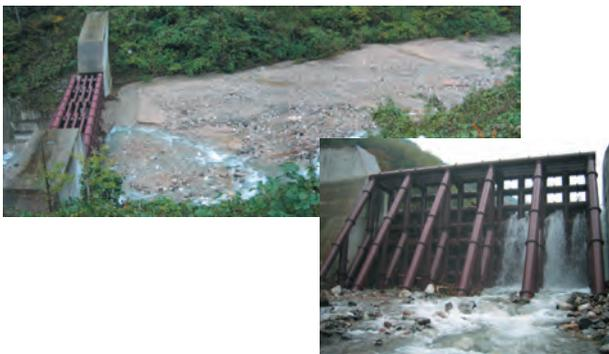
写真-4 最下流えん堤による土石流の捕捉状況
